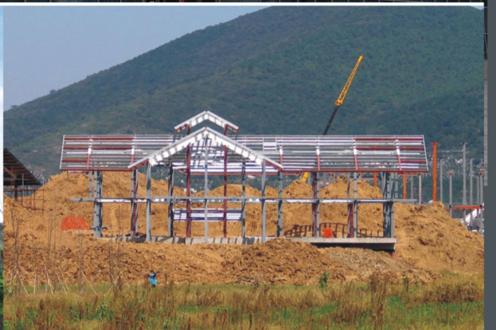
吊装钢结构别墅钢架 National Theatre
