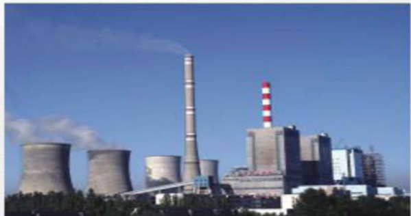
承建的内蒙古神头电厂工程
